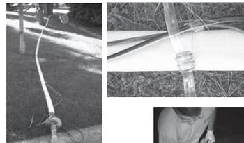
4.- Introducir la bomba en el sondeo e ir bajándola mediante la tubería cuidando que la misma no roce en el borde del entubado.
