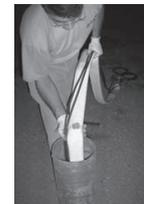
5.- Una vez introducida toda la tubería, colocar la pieza de suspensión sobre la boca del sondeo procurando que quede centrada.
