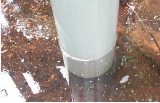
El tubo de bajada o aspiración ha de quedar completamente sumergido en la parte inferior (se recomienda 20cm), para evitar la entrada de aire.
