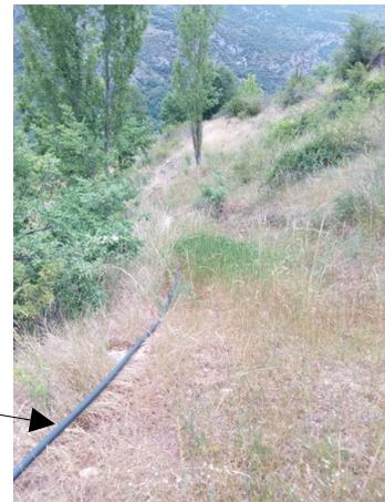
Es muy importante que el tubo una vez instalado no presente ningún sifón (círculos rojos). De ser así el agua no circulará por gravedad (se queda aire en el sifón y no deja
