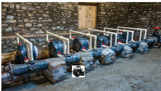
En el caso de turbinas TRG, también se recomienda instalar una válvula, pero en este caso al final del tubo. En los modelo TRG, se utiliza normalmente un tubo pvc flexible (PN6), para la conexión de cada inyector. Se puede realizar en conexiones de PVC, pero al estar los inyectores ligeramente inclinados, las conexiones con tubo rígido no son fáciles. Se recomienda un collarín de toma para cada inyector:
